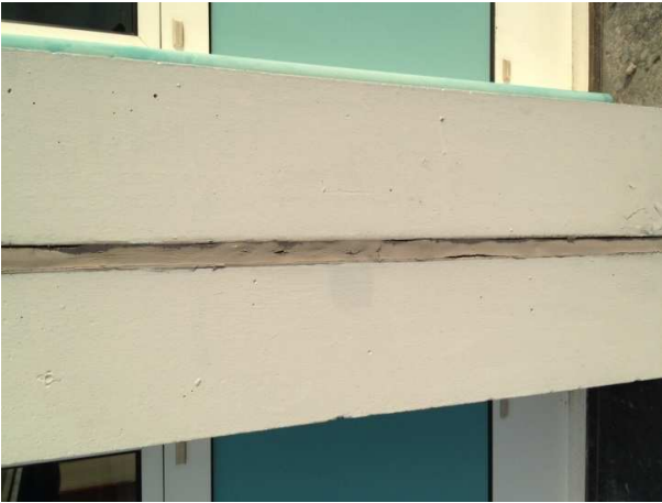
Bild 6: Bewegungsfuge eines Bauwerks; hier: Gebäude A des Campus Paul-Bonatz-Straße der Universität Siegen. Quelle: Prof. Dr. Peter Schmidt
