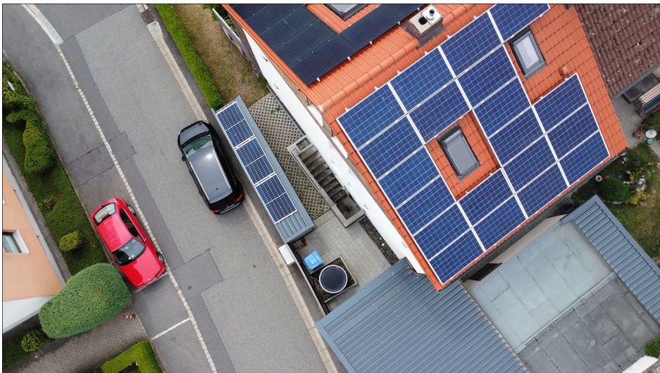
Abbildung 6.14 Das sanierte Dach mit PV-Anlage
