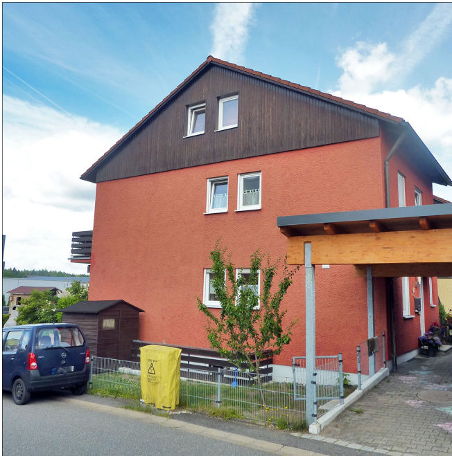
Abbildung 6.12 Das Haus vor Beginn der Sanierung
