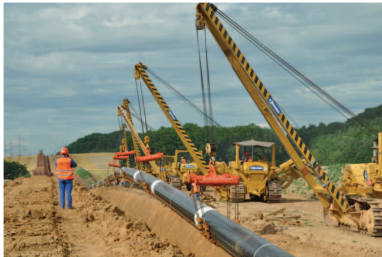
Abb. 2.7 Verlegung einer Erdgas-Pipeline. (Bild: GASCADE)
