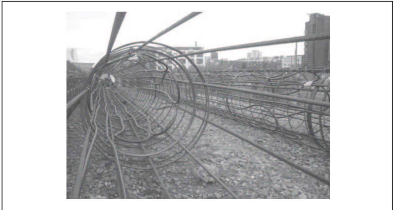
Abb. 4.5-5 Bewehrungskorb eines Energiepfahls
