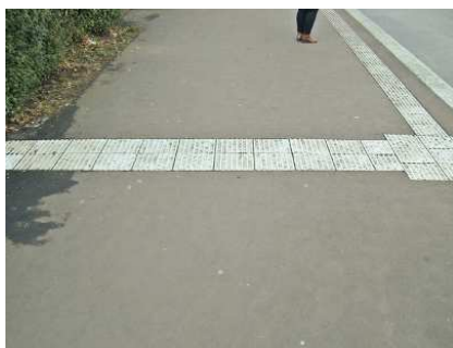
Abb. 5.11: Über die gesamte Gehwegbreite verlegte Bodenindikatoren, die in ein Einstiegsfeld am Haltestellenrand münden
