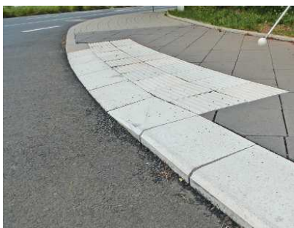
Abb. 5.12: Sperrfeld zur Absicherung des auf Fahrbahnniveau abgesenkten Bordbereichs (Quelle: Blinden- und Sehbehindertenverband Niedersachsen e.V.)
