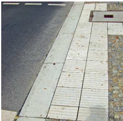
Abb. 5.10: Bodenindikatoren mit Rippenstruktur, die an einer Fußgängerfurt die Überquerungsrichtung anzeigen
