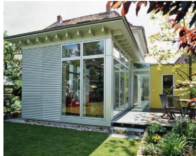
Abb. 2.76: Gartenansicht mit Terrasse
