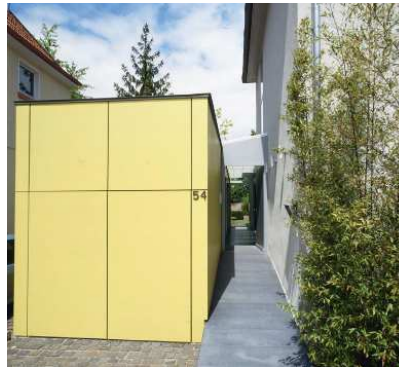
Abb. 2.75: Neuer Zugang mit Rampe zum Erschließungskorridor
