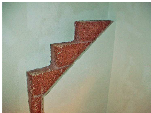
Abb. 5.13: Vorsatzschale mit Leichtbetonsteinen (Quelle: Prof. Gerd Geburtig, Weimar)
