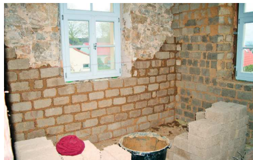
Abb. 5.14: Vorsatzschale auf Naturstein-Außenwand mit Leichtlehmsteinen (Quelle: Andrea Welzig, Niederau)
