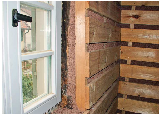
Abb. 5.9: Eingebauter Wärmedämmlehm
