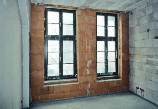
Abb. 5.16: Massive Vorsatzschale aus hoch wärmedämmenden Leichtziegeln als Innendämmung: links vermauert, rechts mit Innenputz beschichtet (Quelle: Schlagmann Poroton GmbH & Co. KG)
