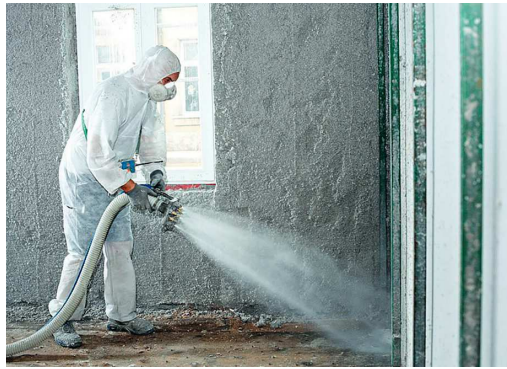
Abb. 5.11: Ansprühen des Zelluloseputzes (Quelle: ISOFLOC)
