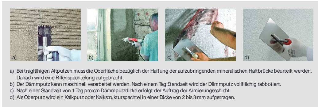
Abb. 5.4: Vorgehen bei Dämmputz (Quelle: Saint-Gobain Weber GmbH)
