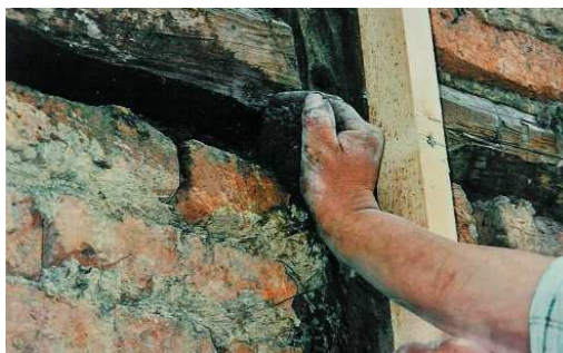
Abb. 5.7: Manuelles „Ausknöten“ von Fehlstellen (Quelle: Haacke Cellco GmbH)
