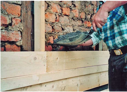
Abb. 5.8: Gleitschalung für Lehmsteinbau (Quelle: Haacke Cellco GmbH)
