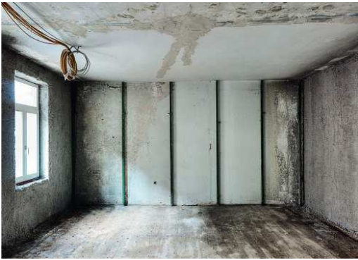
Abb. 5.10: Einbau von Putzlehren (Quelle: ISOFLOC)
