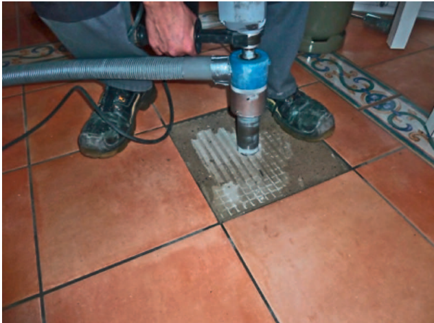
Abb. 5.1: Kernlochbohrung schnell und staubfrei
