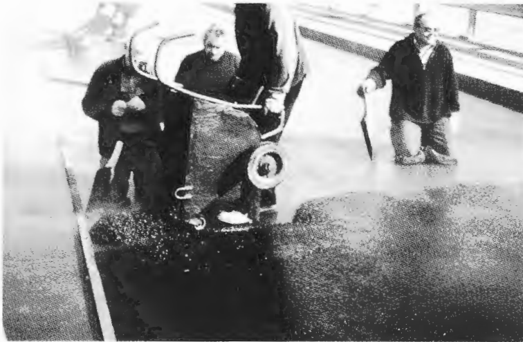
Bild H17 Einbau einer Schutzschicht aus Gussasphalt von Hand
