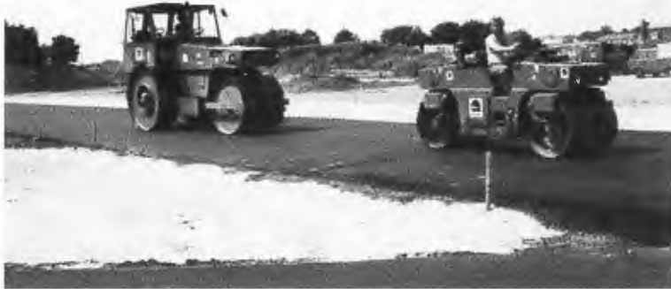
Bild H6 Verdichten von Walzasphalt
