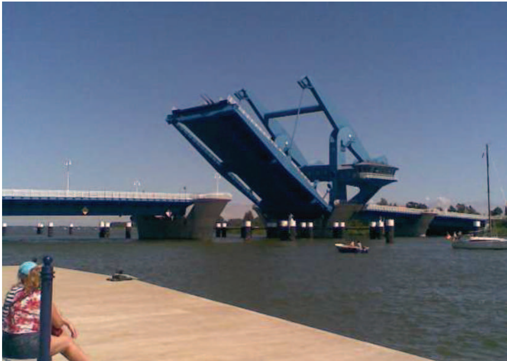
Bild 2-13 Klappbrücke mit Waagebalken in Wolgast
