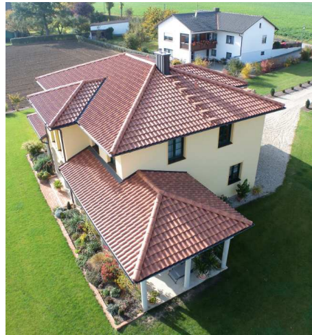
Abb. 5.2: Dreieckige Dachflächen und Parallelogramme
